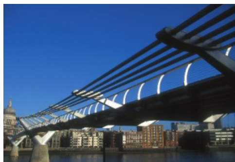
Figura 2.13: Puente del Milenio, Londres.
